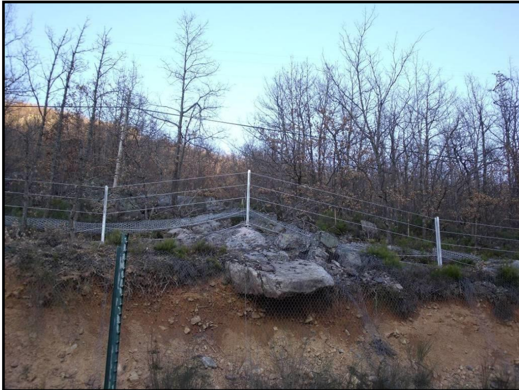
Cables longitudinales
