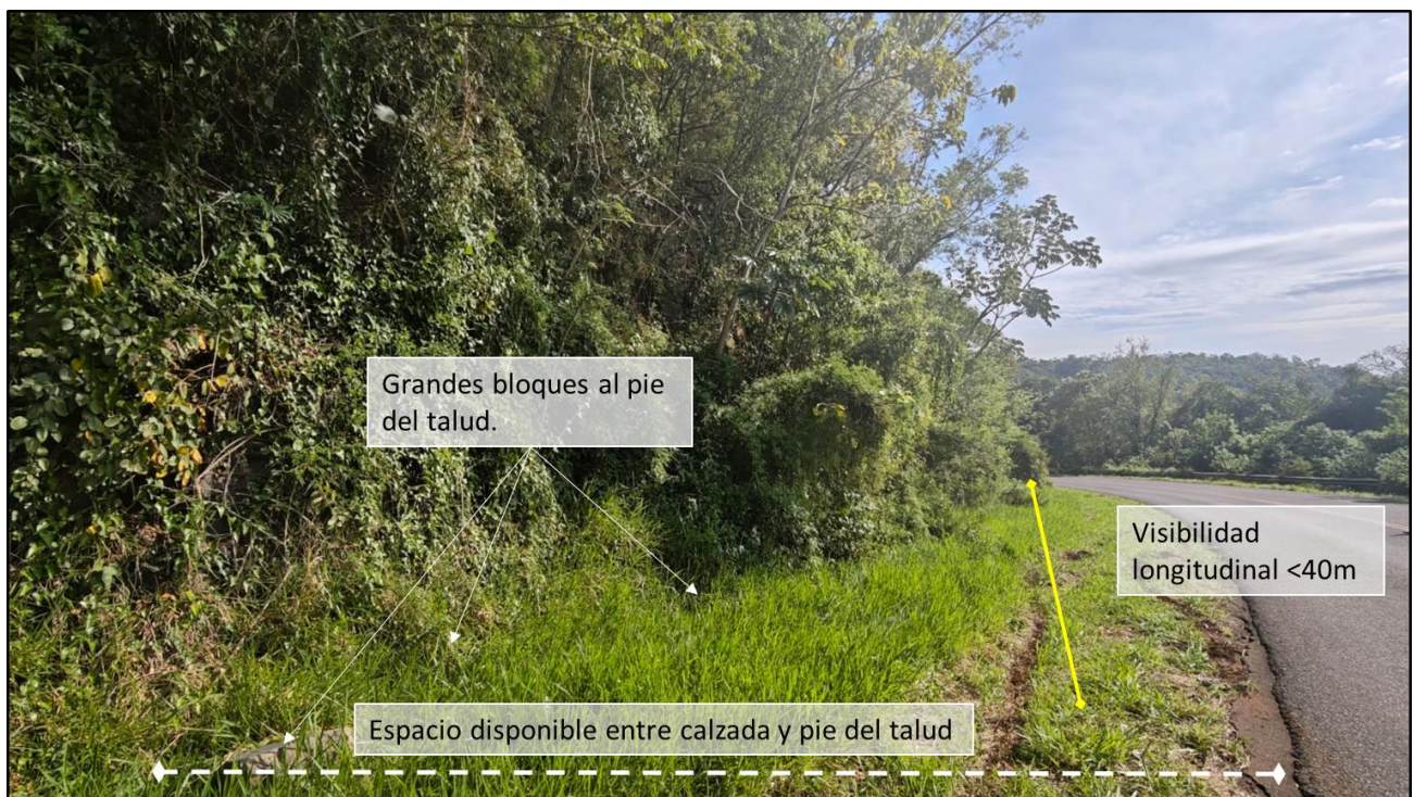
Figura 20: Canal de escorrentía y cono de acumulación al pie del talud, con presencia de bloques de grandes dimensiones.
