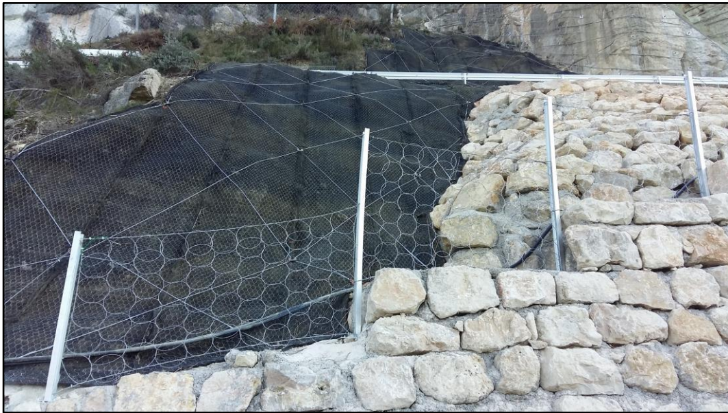
Ejemplo 1 - Disposición de barrera en escalones.
