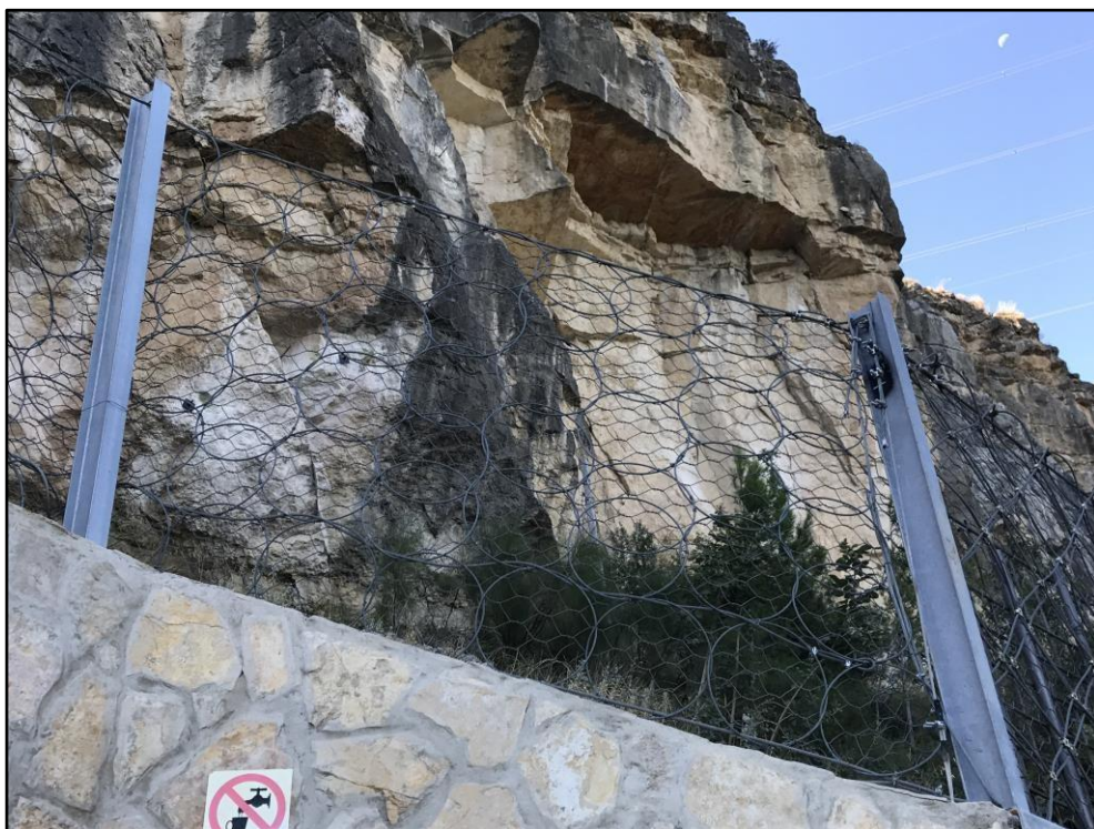
Ejemplo 2 - Detalle de barrera flexible Tipo PMS A
