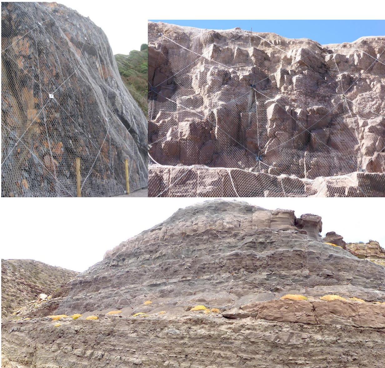
Figura 1: Ejemplos de Malla reforzada con anclajes y cables sobre taludes rocosos
