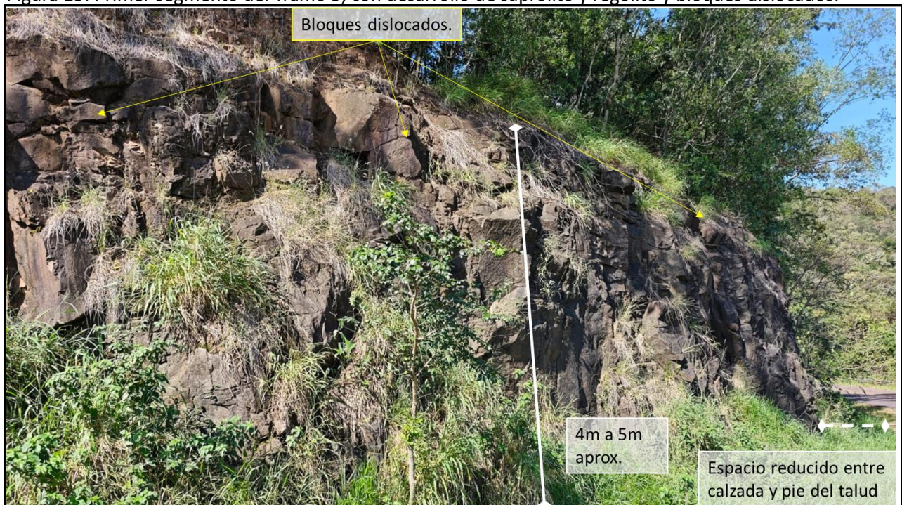
Figura 15: Primer segmento del Tramo 5, con desarrollo de saprolito y regolito y bloques dislocados.
