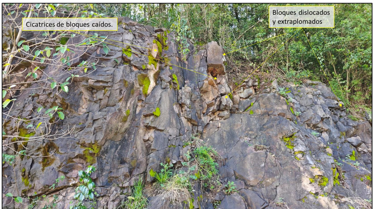
Figura 18: Vista general del Tramo 6 y detalle de bloques individualizados por discontinuidades persistentes.
