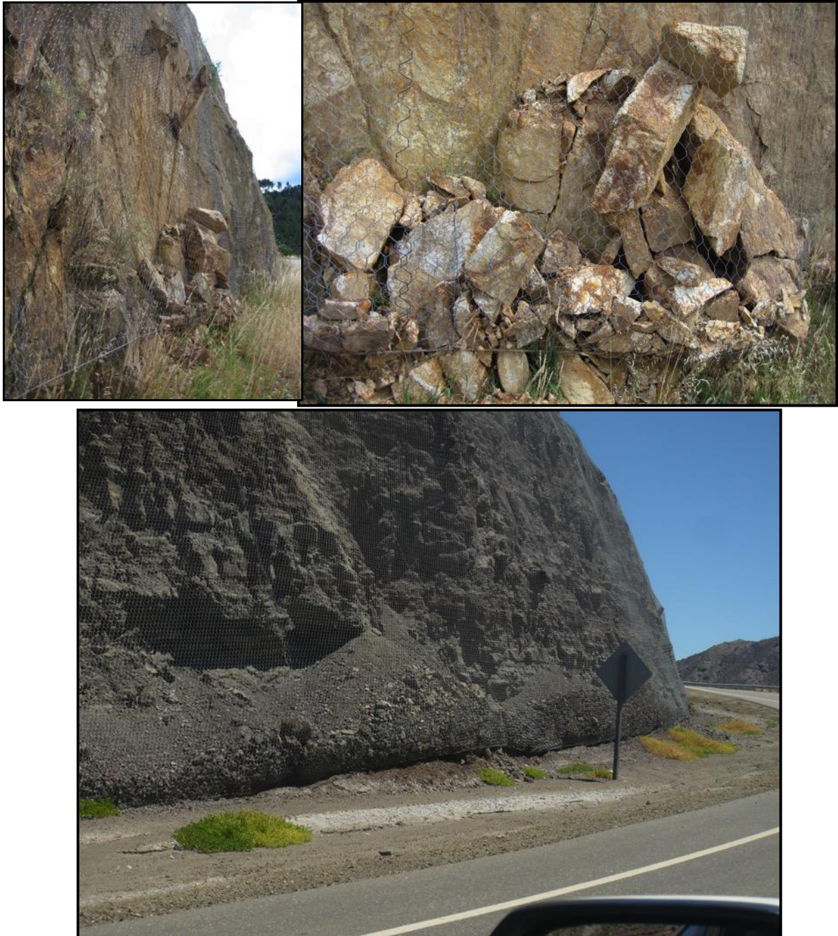
Figura 1: Ejemplos de Malla Colgada sobre taludes rocosos
